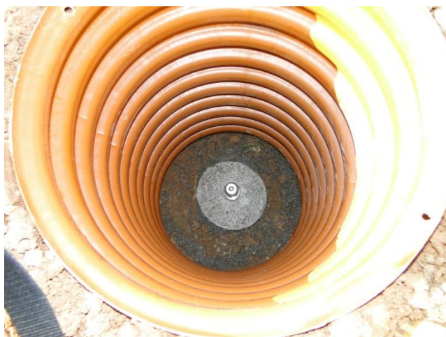
Rys. 18. Reper ziemny zastabilizowany w studziencie drenarskiej. Fot. Autor
